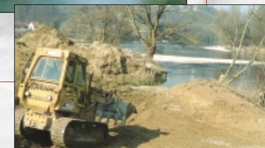
Bauarbeiten im Frühjahr 2003
